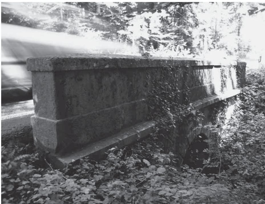
An der Bern-Büren-Strasse. Der kunstvolle kleine Wasserdurchlass auf der Kantonsgrenze wurde in den 1840er Jahren gebaut. Heute rast man achtlos über ihn hinweg. (Foto: Cornel Doswald, ViaStoria)
