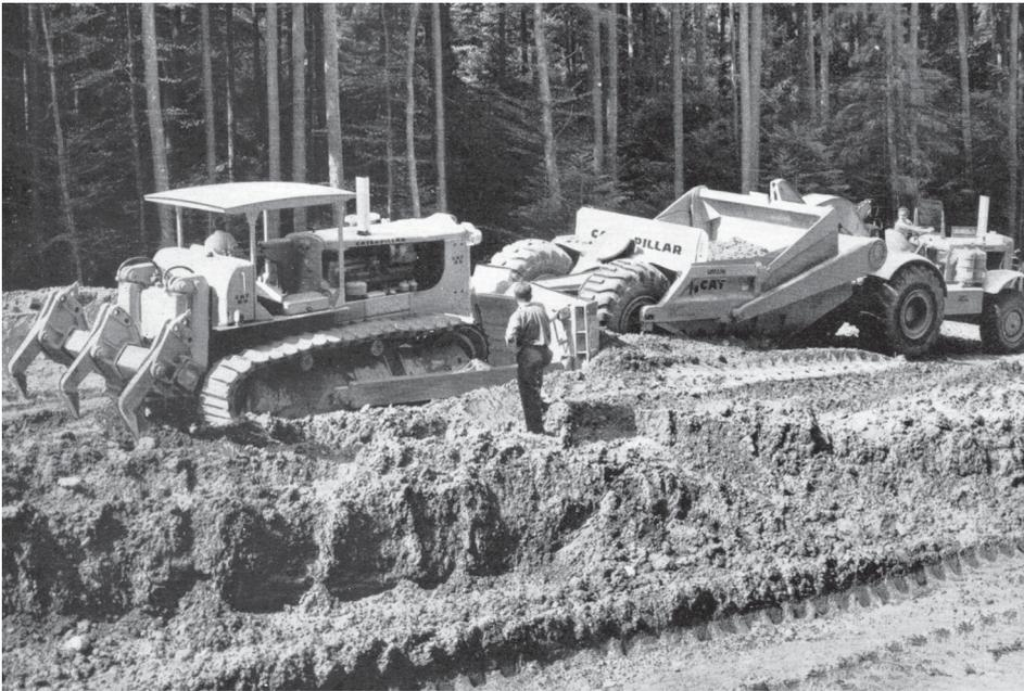
Abb. 51 (oben): Bulldozer und Scraper bei den ersten Autobahnarbeiten an der N1 im Grauholz im Jahr 1959. Zum ersten Mal seit dem Kunststrassenbau der ersten Hälfte des 19. Jahrhunderts wurden wieder im grossen Stil neue Strassen auf vollständig neuer Linienführung gebaut. Die dabei zum Einsatz gelangenden Baumaschinen übertrafen an Leistungsfähigkeit alles bisher in der Schweiz Gesehene. (Foto: Schweizer Autobahnen in Sicht, 1960, 20)
