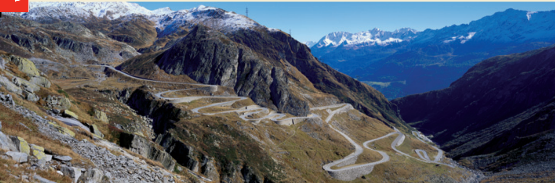
▼ Gotthardstrasse in der Tremola TI
