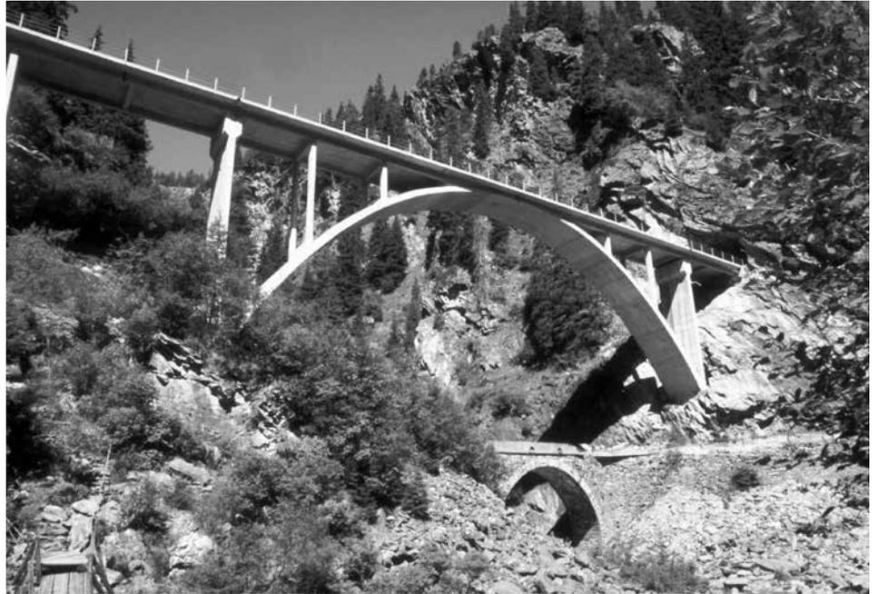
Die als Teil der im Jahr 2005 eröffneten Umfahrung Klosters gebaute Sunnibergbrücke, welche ebenfalls von Christian Menn entworfen wurde, steht für die neueste Brückengeneration. Diese überquert die Landquart in einer Höhe von rund 60 Metern. Die Brücke weist eine Länge von 526 Meter auf. Die Tragseile sind über vier so genannte Pylone gespannt.<sup>93</sup> (Tiefbauamt Graubünden)
