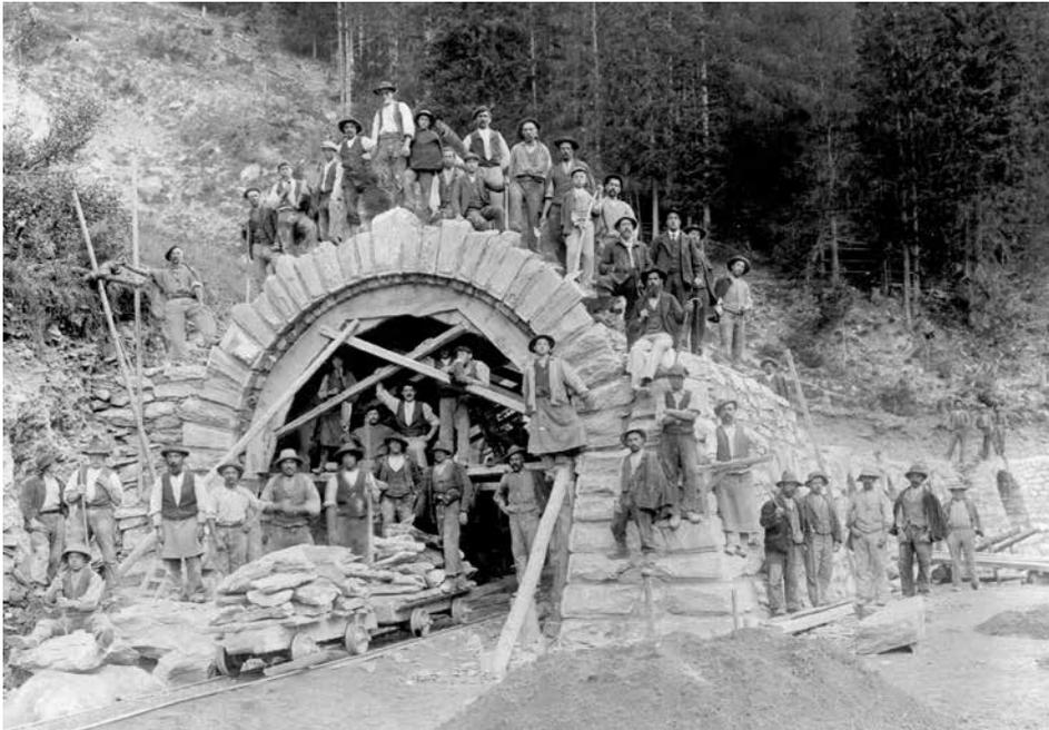
Bau einer Lawingalerie an der Samnauerstrasse im Jahr 1925. Der Tiefbau war bis in die Zwischenkriegszeit hauptsächlich Handarbeit. Entsprechend gross war die Zahl der Arbeiter auf den Baustellen. (Tiefbauamt Graubünden)
