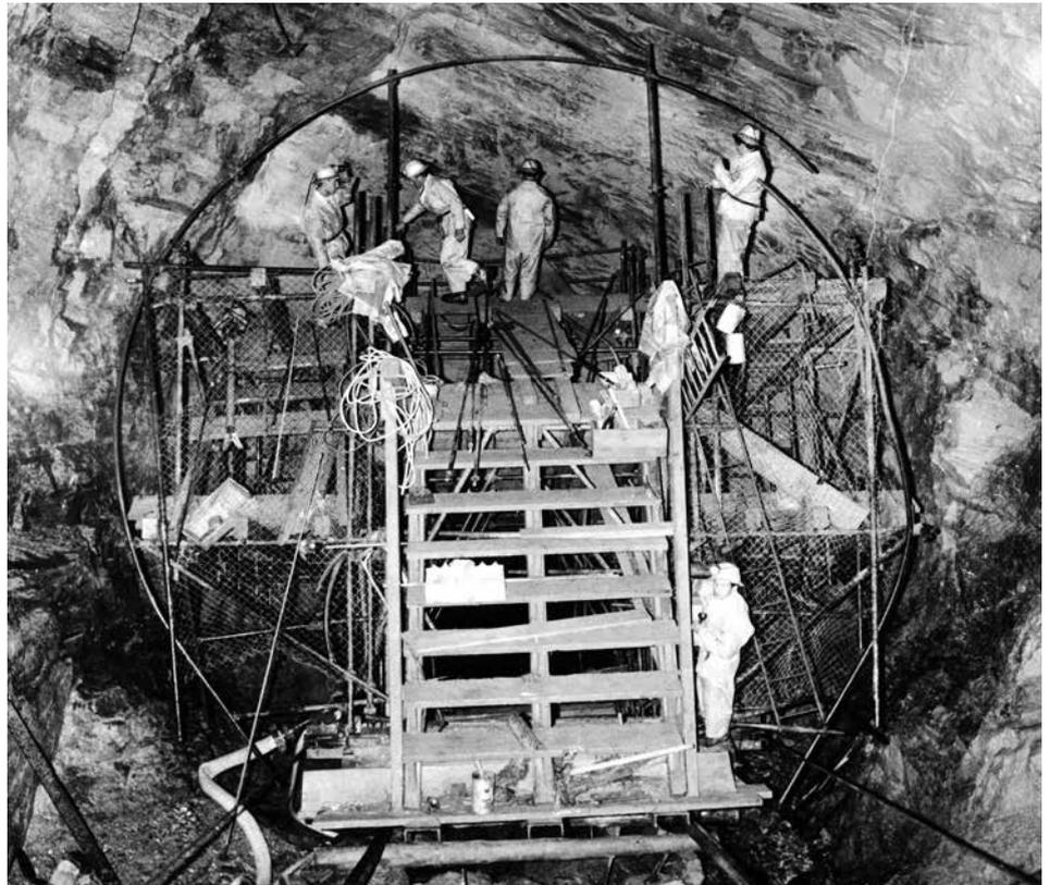
Innenausbau des San Bernardino-Tunnels im Jahr 1964 mit dem Gerüst für die Gewölbekonstruktion. (Tiefbauamt Graubünden)
