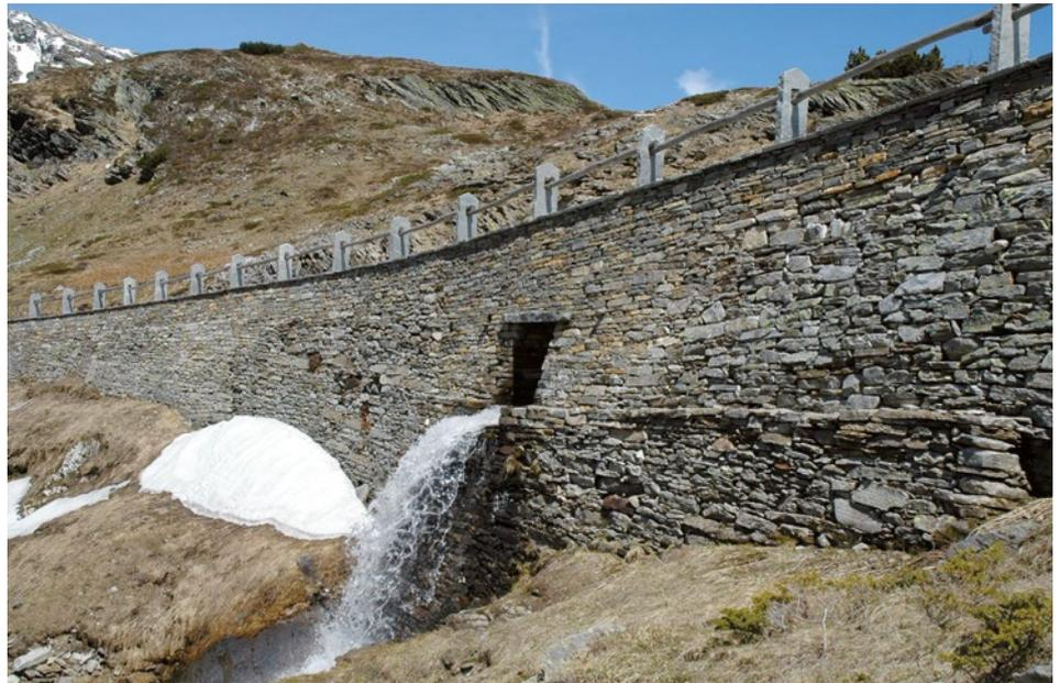
Neuerstellung einer traditionellen Blocksteinmauer beim Ausbau der Oberalpstrasse zwischen Garmischeras und Tscheppa im Jahr 2007. (Tiefbauamt Graubünden)
