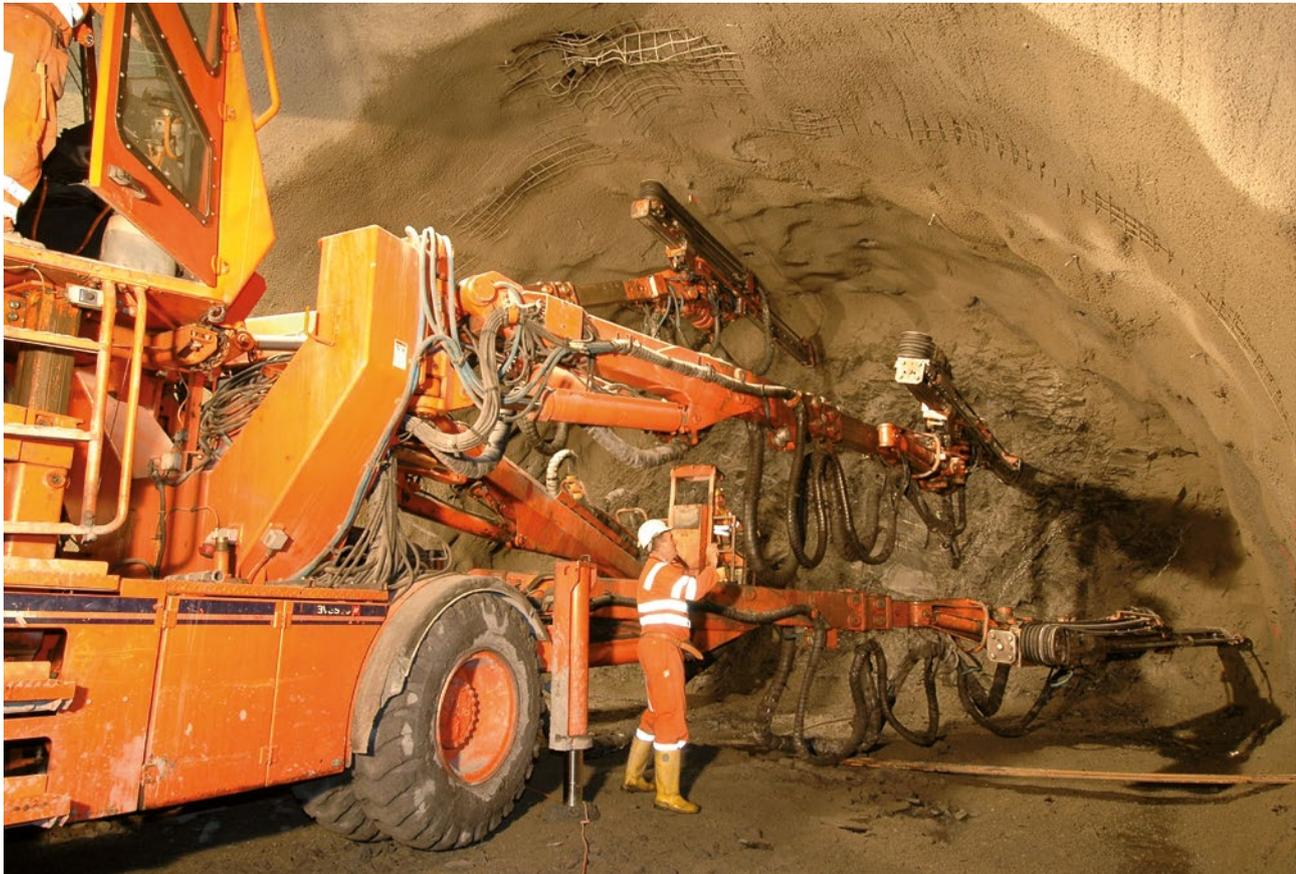
Bau des Umfahrungstunnels Saas (2006), Bohren der Sprenglöcher für den bergmännischen Vortrieb. (Tiefbauamt Graubünden)
