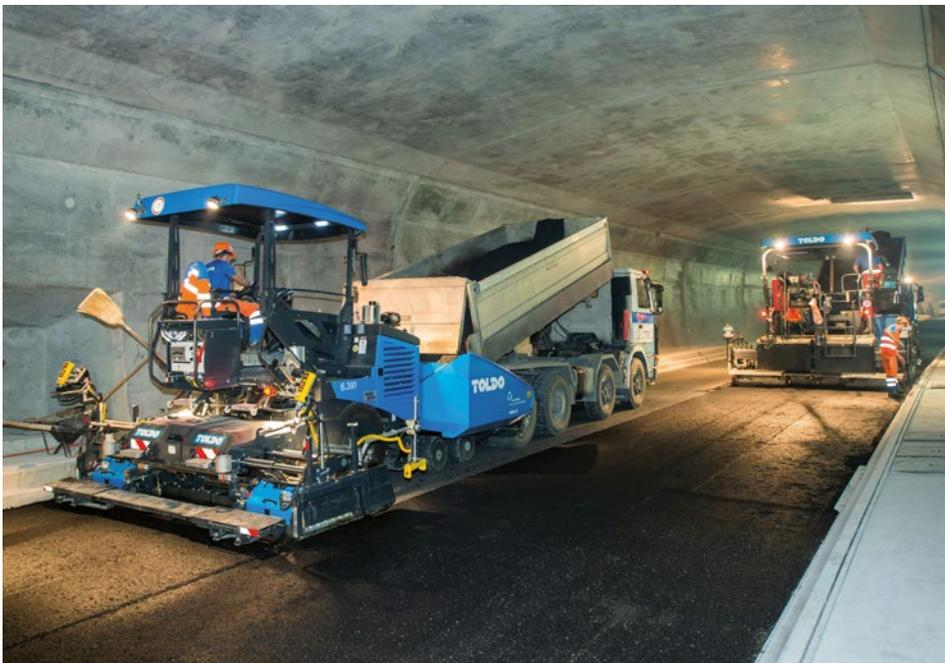
Vollmechanisierter Belags-einbau im Umfahrungs-tunnel Küblis im Jahr 2014. (Tiefbauamt Graubünden)
