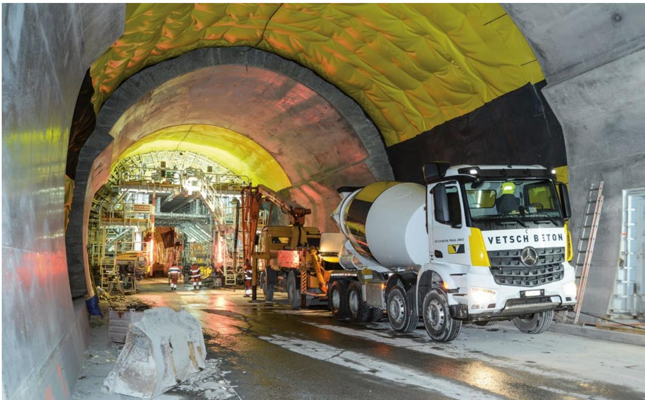
Bau des Umfahrungstunnels Küblis (2013), Betonieren des Innenringes. (Tiefbauamt Graubünden)
